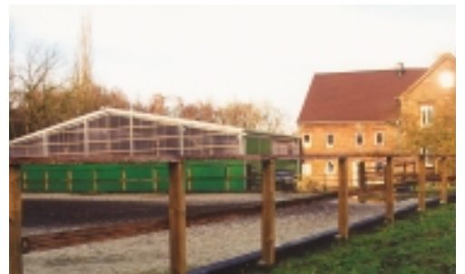
Zentrum für therapeutisches Reiten der „Werkstätten der AWO Dortmund GmbH“ in Lünen
